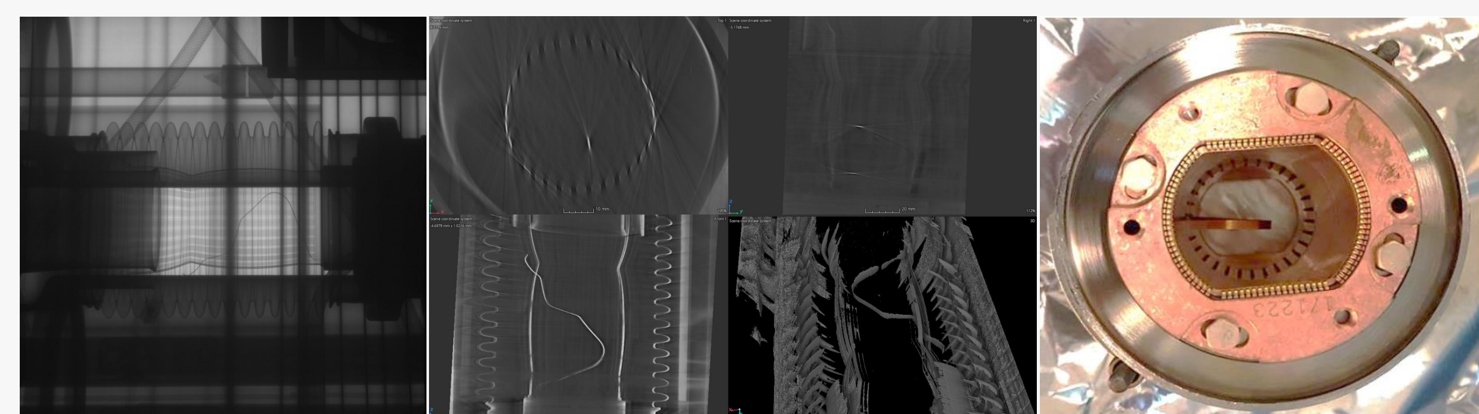
Recherche de déformations de doigts radiofréquence dans l'interconnexion QQBI.21L3 Détection par radioscopie Visualisation 3D de la déformation Vue du doigt déformé après démontage
