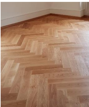
Remise en état
